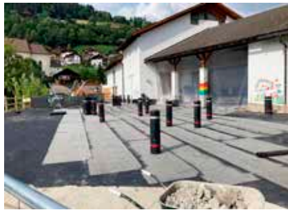
Isolierungsarbeiten wegen Wassereintritt am Dach Probelokal
