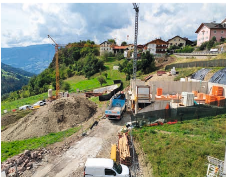
Baubeginn Wohnbauzone Durns
