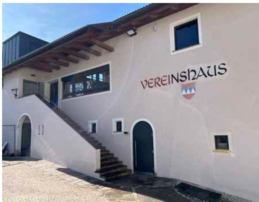
Vereinshaus Teis mit neuem Aufzugsschacht an der Ostseite
